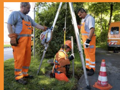
Observarea și inspecția vizuală a canalelor mari
