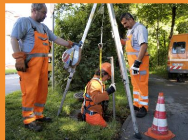
Observarea și inspecția vizuală a canalelor mari
