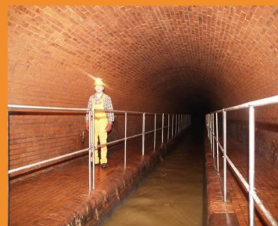
Observarea și inspecția vizuală a canalelor mari
