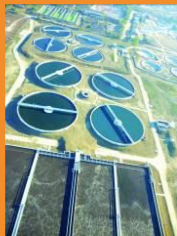
Stația de epurare Stan Vidrighin
