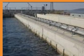
Stația de epurare Stan Vidrighin, Separatoarele de grăsimi și deznisipatoarele
