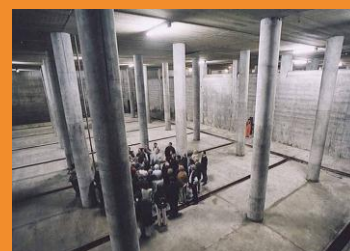
Bazin de retenție apă pluvială din sistemul de canalizare din München
