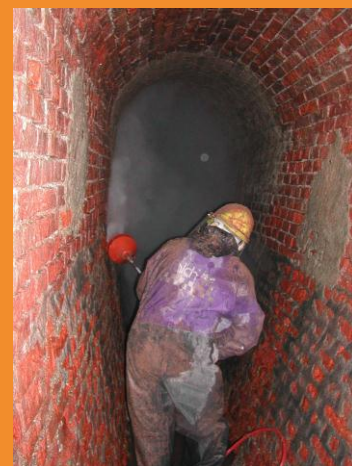
Procedură de reabilitare a canalului prin jet de apă sub presiune
